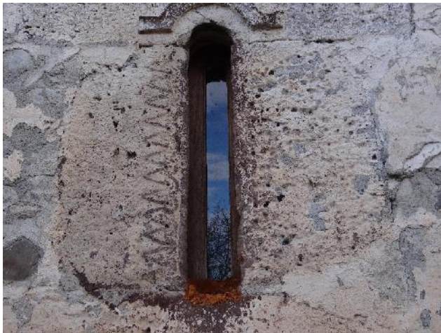
აღმოსავლეთ ფასადის სარკმელი The window on the eastern façade of the church
